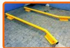
DT-GR - Guia de Rodas para facilitar a manobra do veículo durante a aproximação a doca, garantindo um correto posicionamento, com estrutura em tubos de aço fixada ao piso com parabolts.
